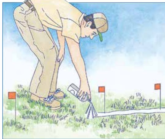
Antes de hacer la zanja, utilice pequeñas banderas y pintura en aerosol para hacer un esquema del sistema de riego.
