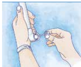
Modo de montar el PVC: 1. Coloque la cola dentro del accesorio y afuera del tubo.
