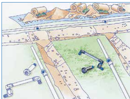
Tienda los tubos y aspersores cerca de las zanjas en las que serán instalados.
